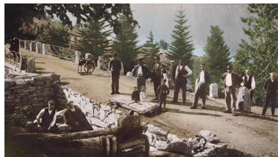
Bygging av riksvegen. Foto: Isak Hellebust. Kjelde: Fylkesarkivet.
