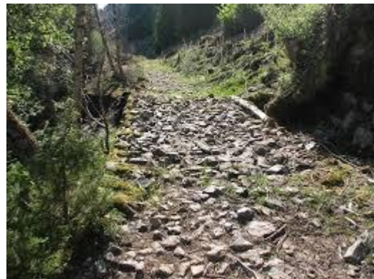
Kjerrevegen mellom Indre og Ytre Furefjerding, bygd av Johan O. Lillestøl. Foto: Fylkesarkivet.
