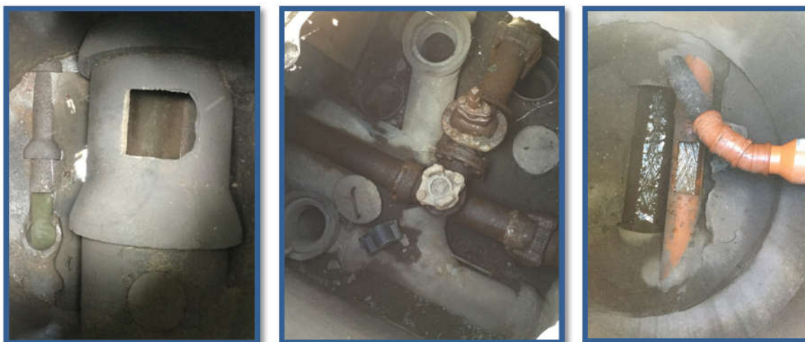
Figur 13 Eksempler på overløpsmulighet. Til venstre: Kum der et behov for tilgang i forbindelse med drift, har ført til at det er laget hull i toppen av begge ledningene. I midten: kum der det i utgangspunktet er montert lokk på overvannet og spillvannet. Disse lokkene er ikke tette og vil uansett ikke ha full funksjon selv om de hadde vært på plass. Til høyre: kum med to åpne renner.
