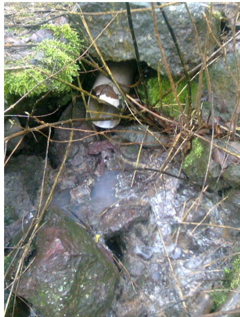
Figur 26 Urenset gråvann til utslipp i bekk.
