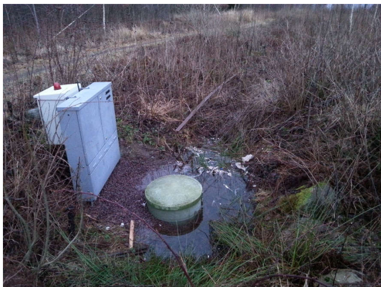
Figur 28 Oversvømmelse og forsøpling etter stans av privat pumpekum.
