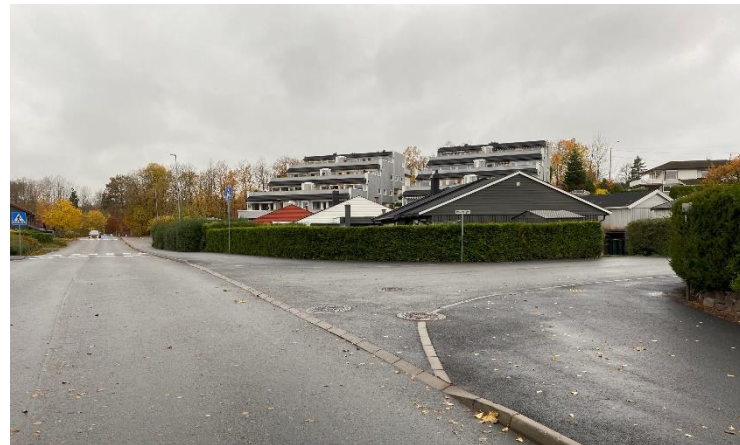
Figur 10 viser krysset mellom Bjørnestien og Beverstien etter kryssutbedringene. Her er det tydelig radier i svingen og tydelig for gående at fortauet ikke krysser veien.
