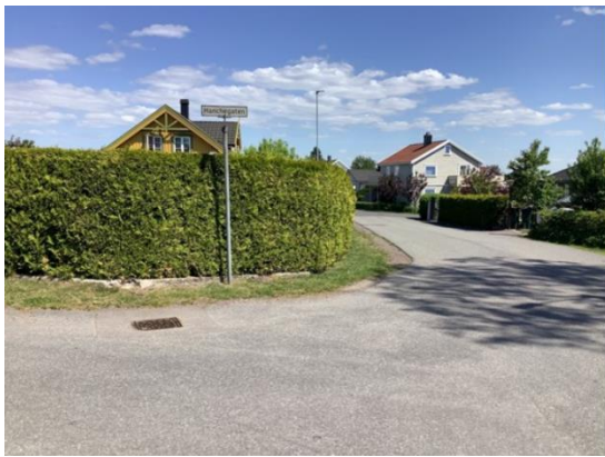
Figur 11 viser krysset før vegetasjon er fjernet. Høye hekker skaper dårlig sikt
