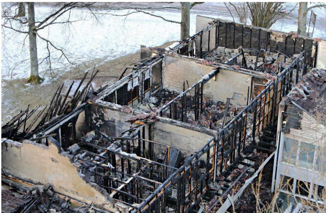
Figur 1, Bilde av nedbrent bygning - Borre 2017(kilde VIB)
