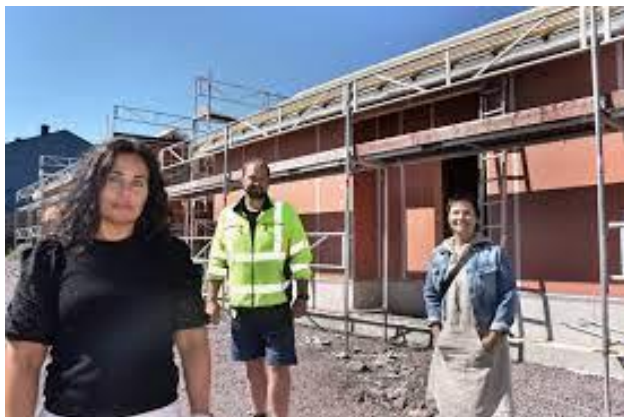
Småhus som bygges i Bassengparken. Et nytt tilbud som Horten har manglet
