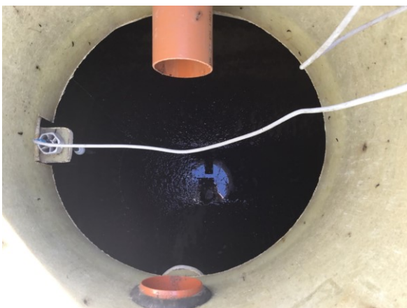
Figur 4 - Tett tank med nivåvarsler.
