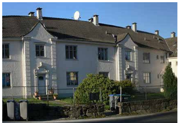
Boliganlegg i Svaneviksveien, Årstad. Foto: Jon Hoem.
